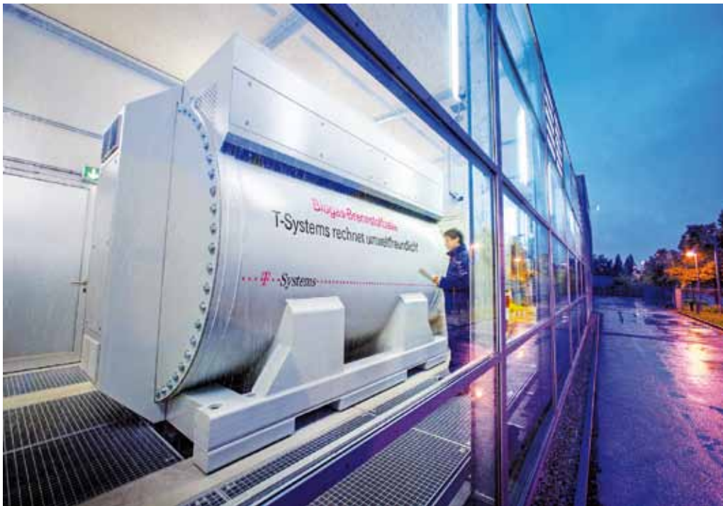
Eine Brennstoffzelle liefert Strom und Kälte für den Serverraum in München
